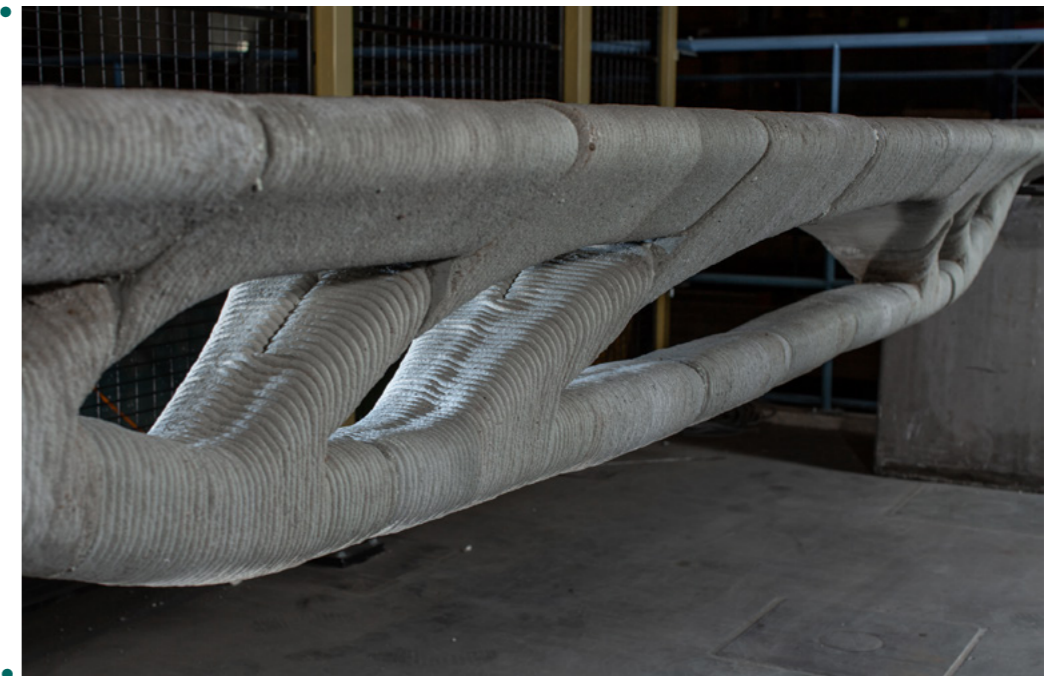
BETONNEN 3D-GEPRINTE BRUG FOTO VERTICO
