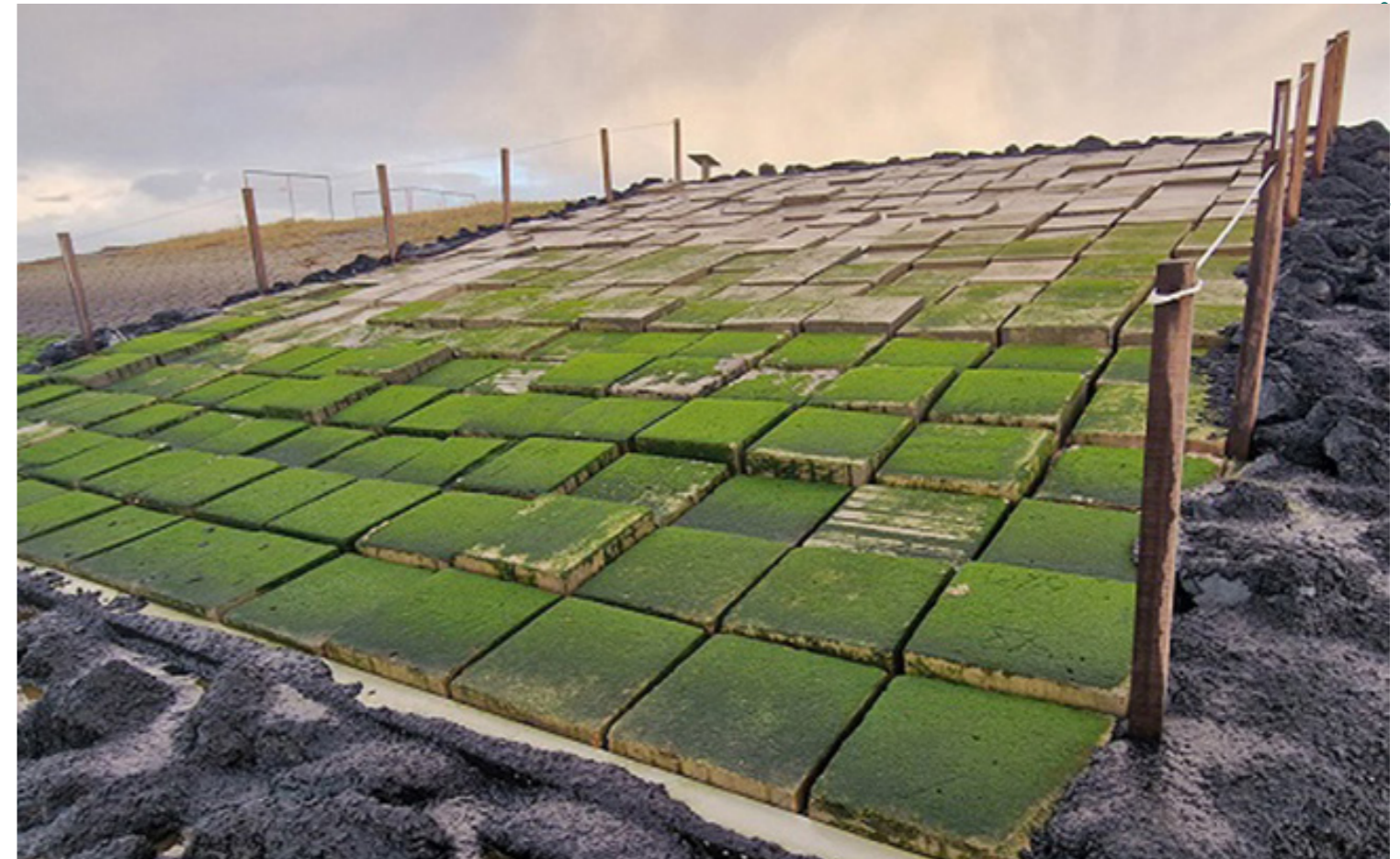
GEOWALL GEMAAKT VAN BAGGER FOTO NETICS
